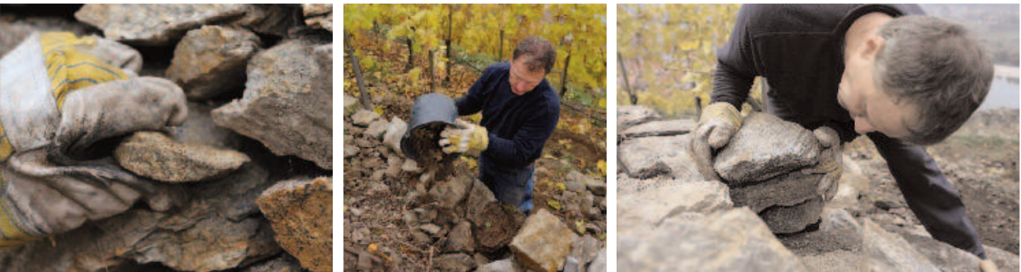
Meisterliche Handwerkskunst, bei der jedes Detail wichtig ist, um die Langlebigkeit der Mauer zu garantieren. Vom sorgfältigen Verkeilen über das Hinterfüllen mit Füllsteinen. Jeder »Baustein« kommt präzise auf seinen Platz.
